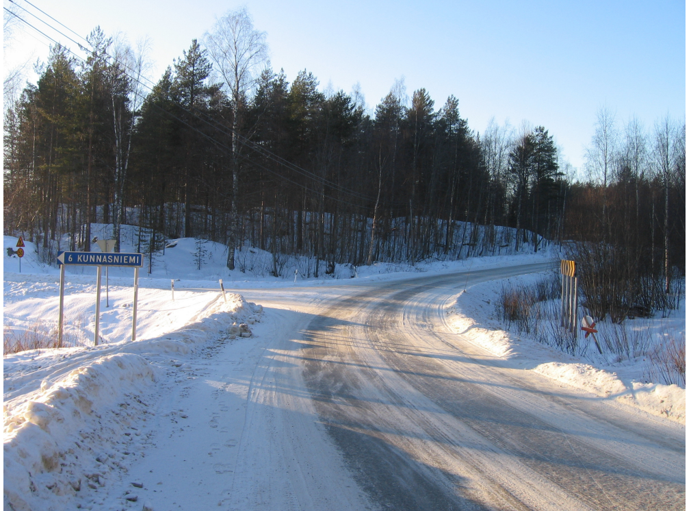
Kuva 4.6. Huhmarisentien moottorikelkkareitti sijaitsee liittymän läheisyydessä ja tien geometria aiheuttaa myös näkemäongelmia. Ylituskohdan molemmin puolin esitetään asetettavaksi varoitusmerkit.
