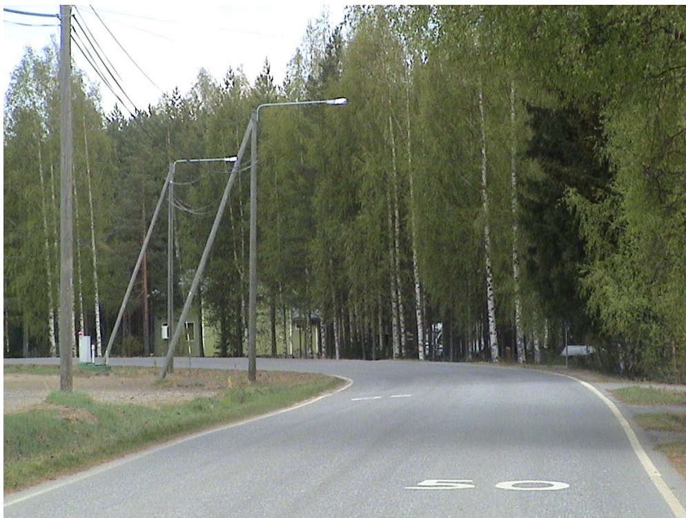
Kuva 4.9. Sotkuman koulun liittymä Käsämäntiellä sijaitsee jyrkähkössä kaarteessa.
