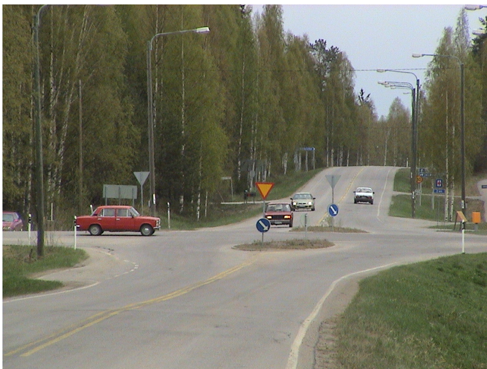
Kuva 4.5. Seututeiden 504 ja 502 liittymä Kylylahdessa on yksi Polvijärven ongelmallisimpia kohteita. Liittymä esitetään parannettavaksi kiertoliittymänä.
