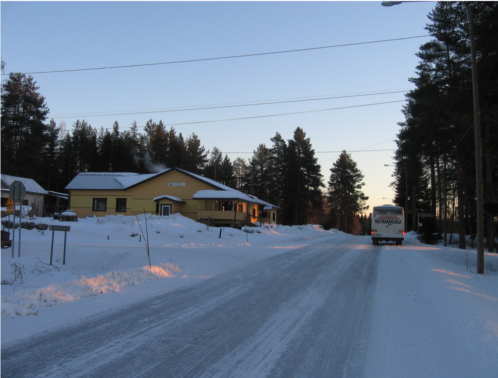
Kuva 4.8. Ruvaslahdentien ja Noisniementien liittymässä näkemä on heikko Oriniemen suuntaan johtuen Ruvaslahdentien geometriasta.
